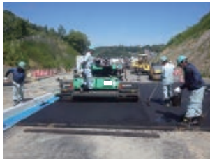
尾道市門田町 一般国道184号道路改良工事
