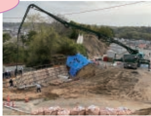
尾道市門田町 一般国道184号道路改良工事
