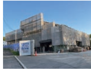
尾道市高須町 (仮称)尾道地区学校給食センター
