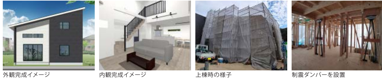
外観完成イメージ 内観完成イメージ 上棟時の様子 制震ダンパーを設置
