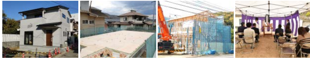
尾道市向東町 Y邸まもなく完成！ 尾道市美ノ郷町 O邸基礎工事完了 尾道市木ノ庄町 M邸上棟 尾道市吉浦町 N邸地鎮祭
