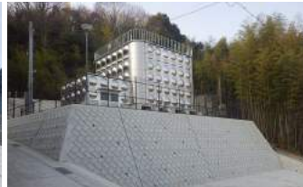
尾道市高須町 阿草配水池築造工事
