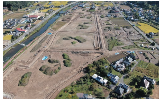
尾道市御調町 県営ほ場整備工事
