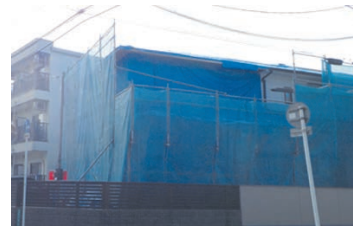
福山市今津町 K 邸改修工事
