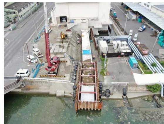
福山市高西町 高西東新涯ポンプ場 土木工事
