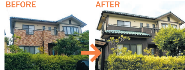
尾道市高須町 S邸増築工事
