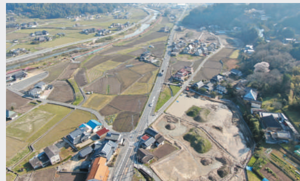
尾道市御調町 県営ほ場整備工事
