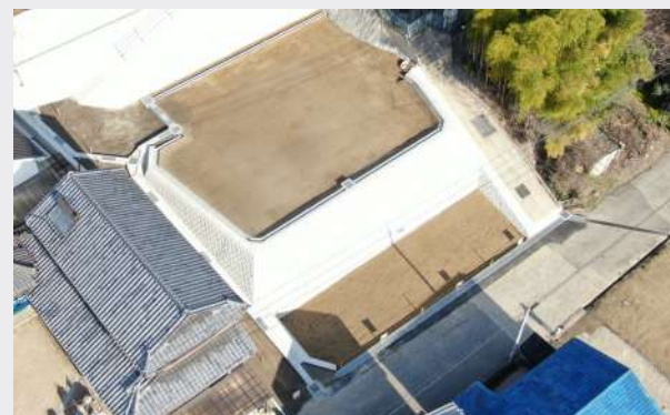
尾道市高須町 阿草配水池築造工事
