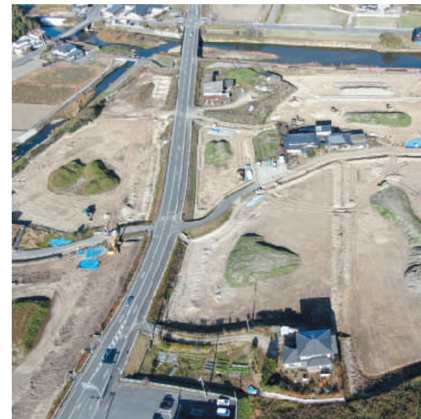
尾道市御調町 県営ほ場整備工事
