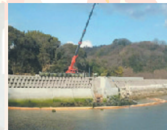
尾道市向東町 県営海岸保全護岸工事
