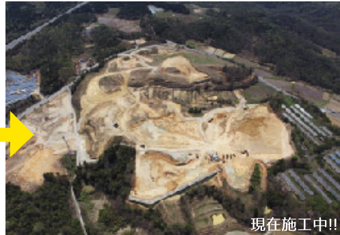
現在施工中!! 2017年4月撮影
