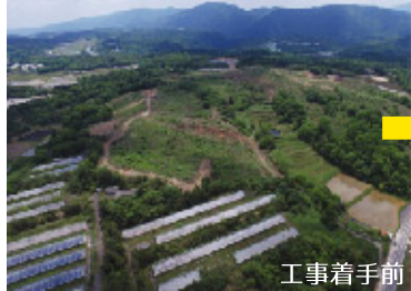
工事着手前 2016年5月撮影
